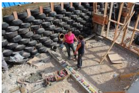
La structure en pneus et terre compactée
